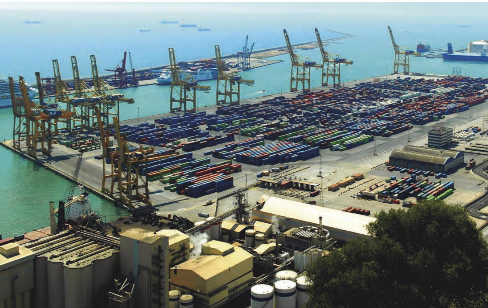
▲ Port Comercial de Barcelona. Fotografia: Gettyimages.
